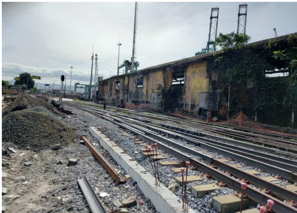
Figura 58 - Vistas do início do Armazém 2 e o Armazém 1 agora em direção ao lado dito São Paulo
